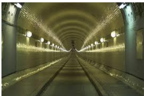
der alte Elbtunnel
